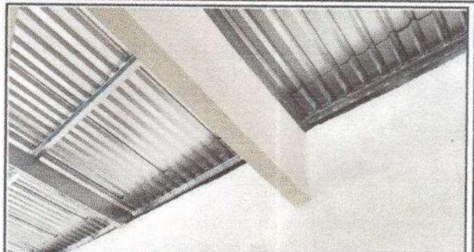
Foto 2: Sustitución de lámina, por lámina troquelada 13 pies
