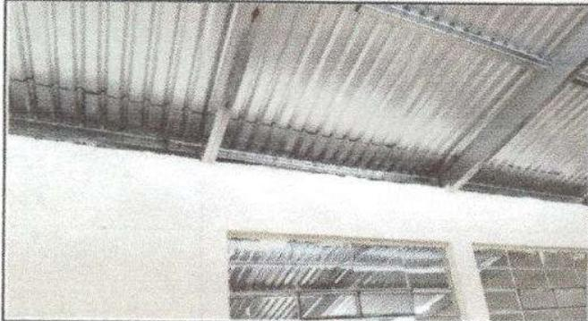
Foto 1: Sustitución de lámina, por lámina troquelada 23 pies
